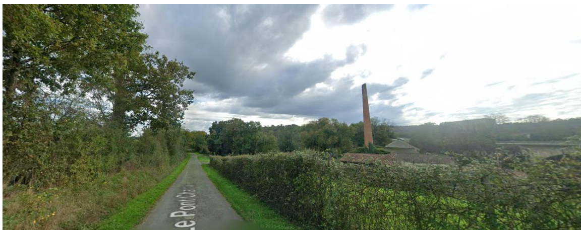
Figure 17 : découverte du moulin par les voies communales (source Google StreetView)
