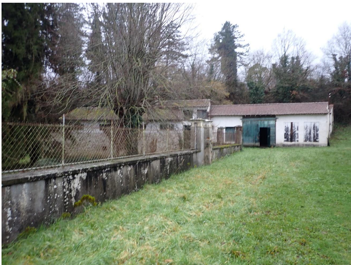
Figure 25 : Dépendances sans enjeu patrimonial (cf figure 5 : bâtiment F) (Source Ouest am')
