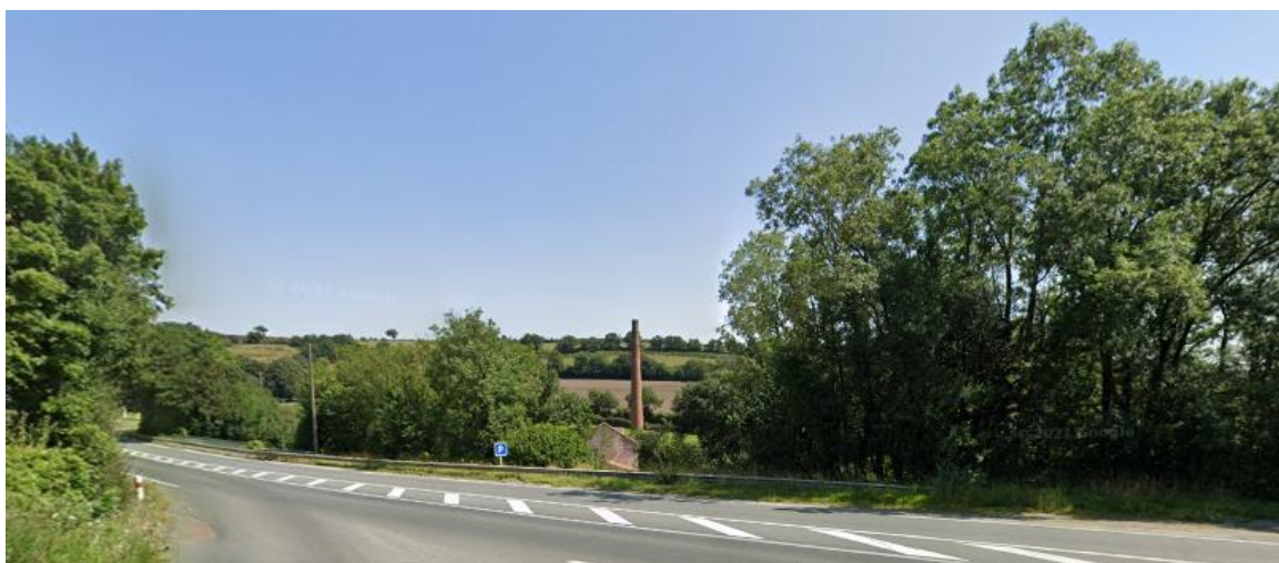
Figure 19 : Route départementale 137 à hauteur du moulin (source Google StreetView)
