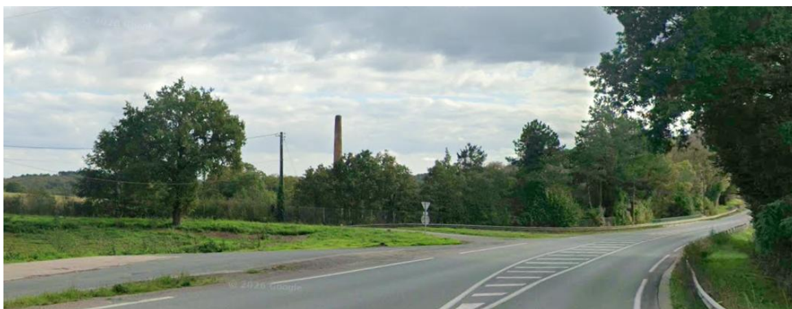
Figure 18 : vue de la cheminée à partir de la RD 137 en venant de Chantonay et en entrée d'aire de repos (source Google StreetView)
