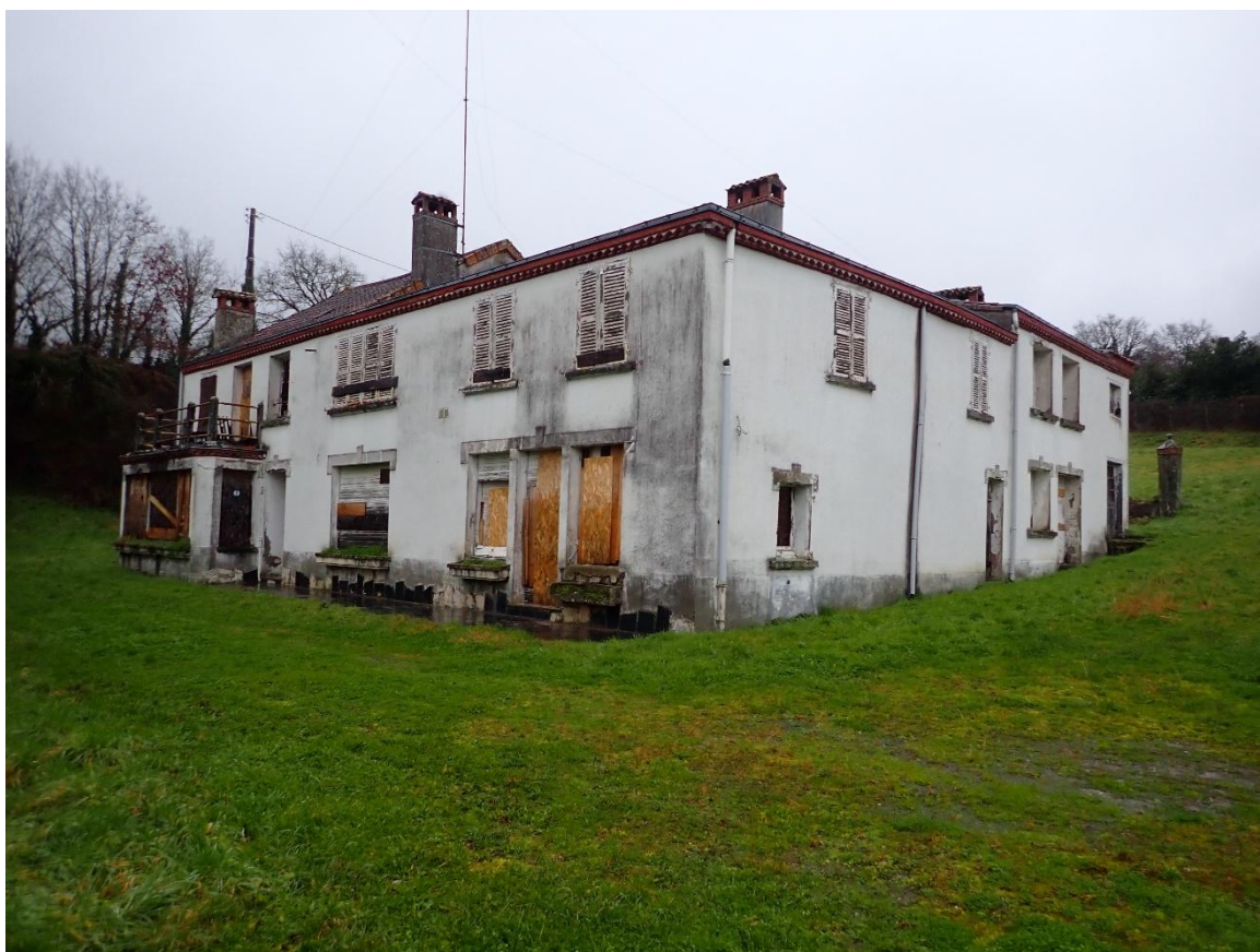
Figure 24 : Ancienne auberge (cf figure 5 : bâtiment B) (Source Ouest am')
