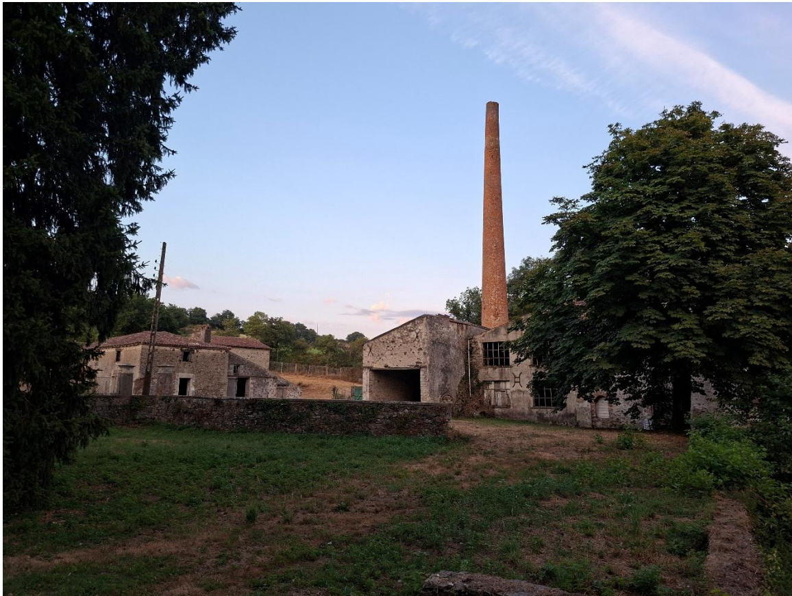
Figure 14 : Vue d'ensemble (cf figure 5 : bâtiment A et C) (source Ouest am')
